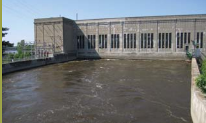
Barrage hydroélectrique du 25, rue du Pont Drummondville
