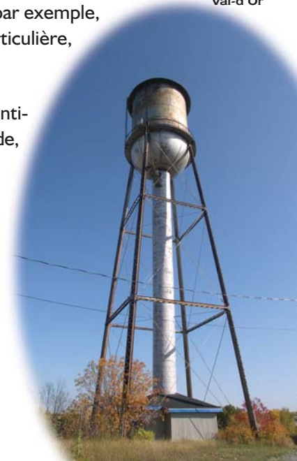
Château d'eau de l'ancienne mine Sullivan Val-d'Or
